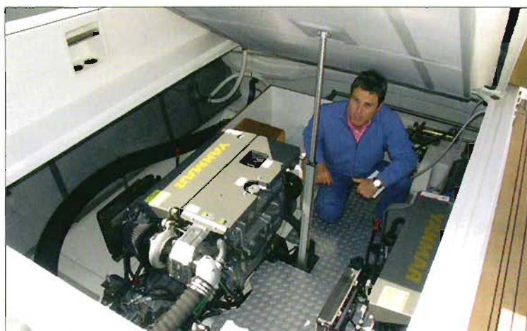
La cale moteur est parfaitement organisée. La place ne manque pas et des coffres permettent de stocker beaucoup de matériel.
